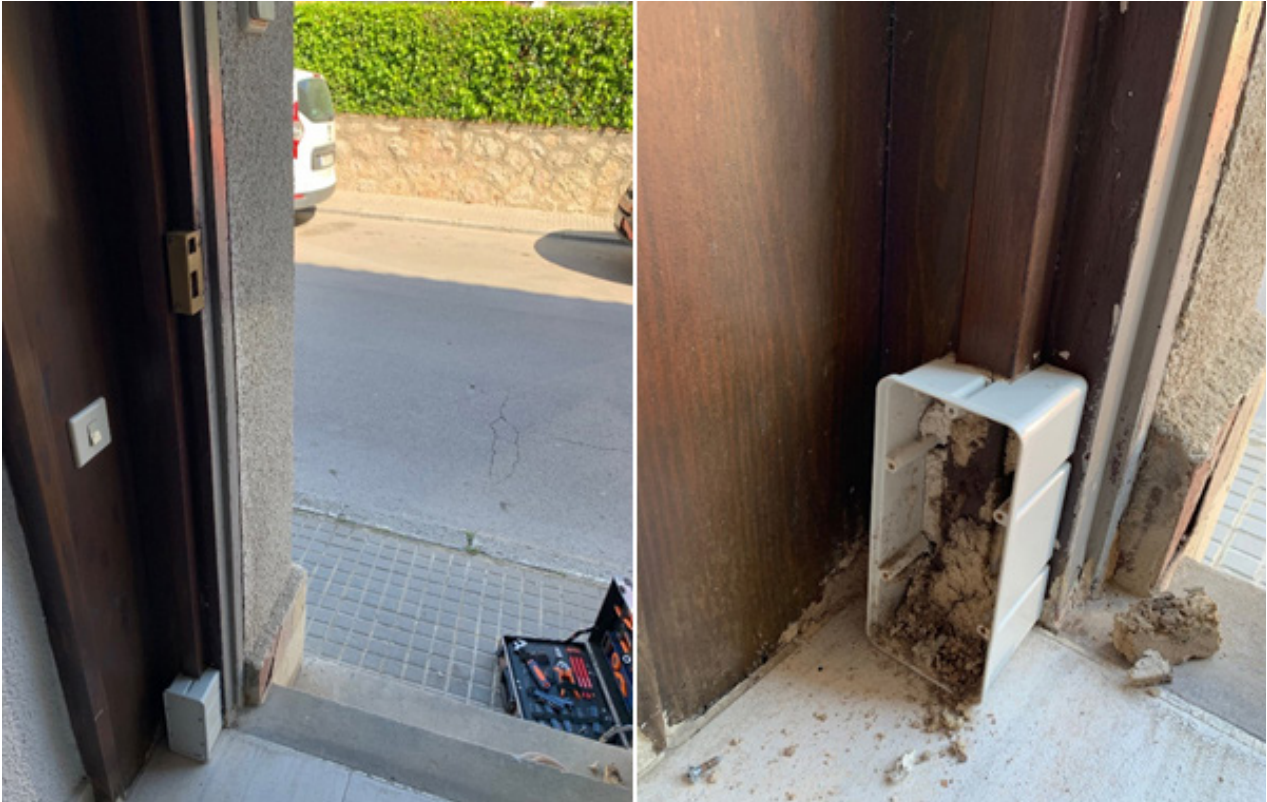
Figura 4. Ubicación de la caja-cebo para termites en el marco de un portal infestado (A). Detalle de la caja-cebo abierta (B).
