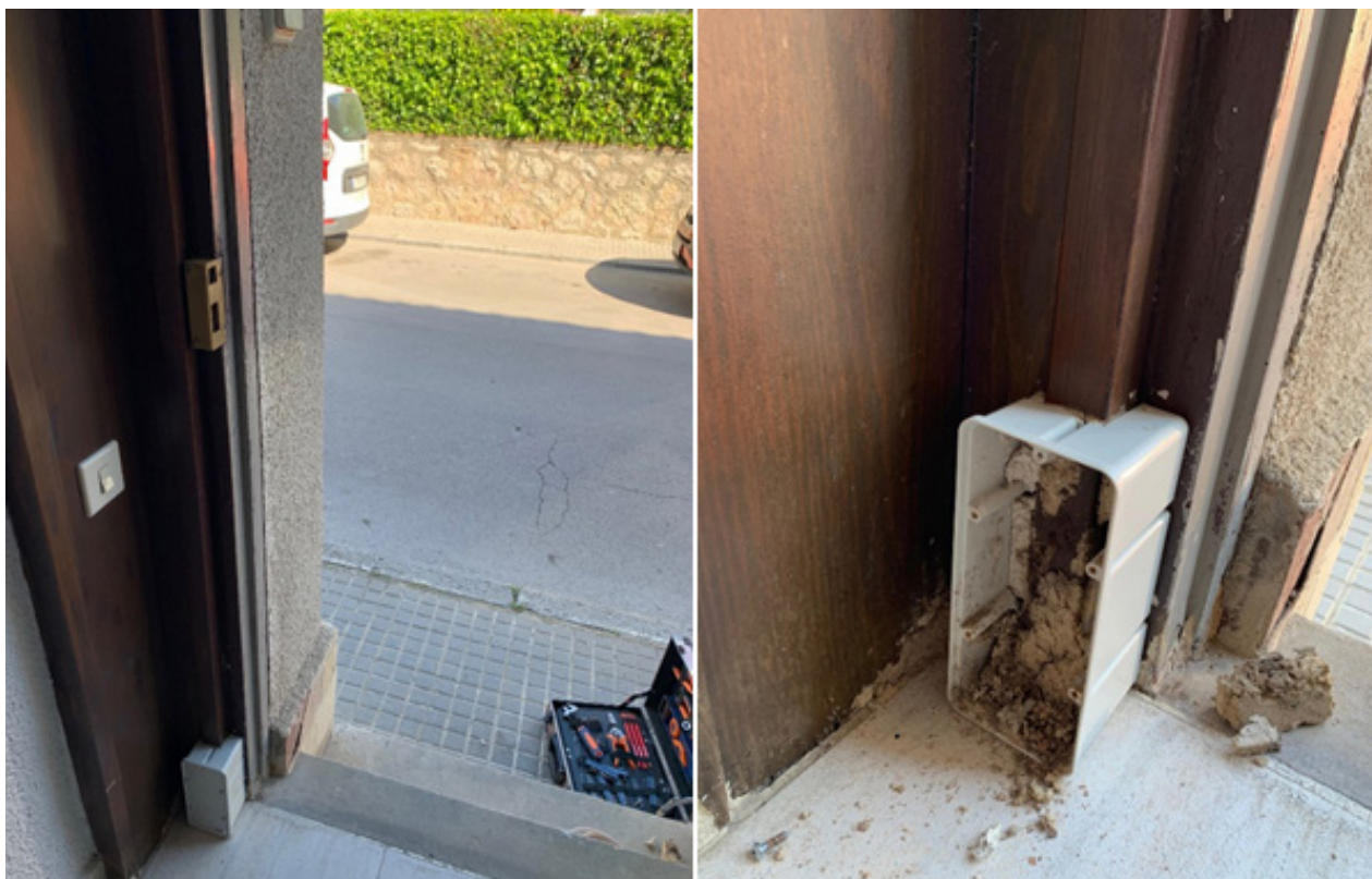
Figura 4. Ubicación de la caja-cebo para termes en el marco de un portal infestado (A). Detalle de la caja-cebo abierta (B).
